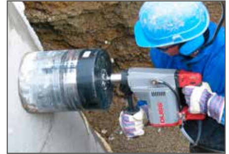
Aanboren van betonnen schacht – nat, handgestuurd
